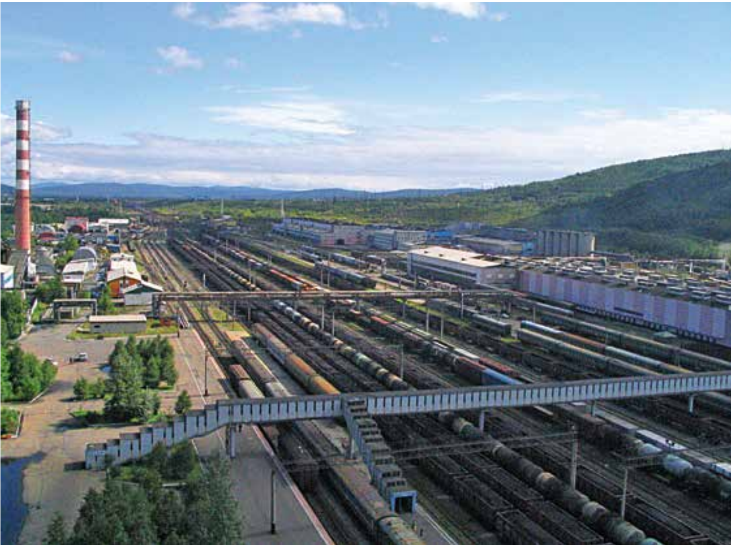
РЕАЛИЗАЦИЯ ПРОЕКТА ПО РЕКОНСТРУКЦИИ БАЙКАЛО-АМУРСКОЙ И ТРАНССИБИРСКОЙ МАГИСТРАЛЕЙ ПОЗВОЛИТ НАСЫТИТЬ ИНФРАСТРУКТУРОЙ ОГРОМНУЮ ТЕРРИТОРИЮ
